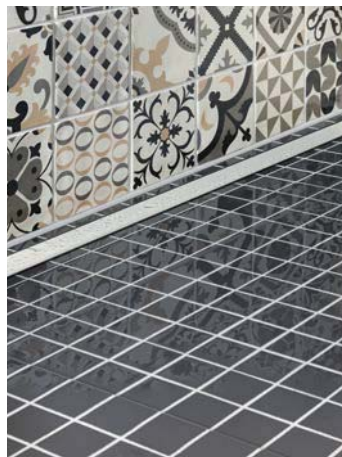
Rollstuhlbefahrbar bei einer Fliesengröße ab 50 x 50 mm.
