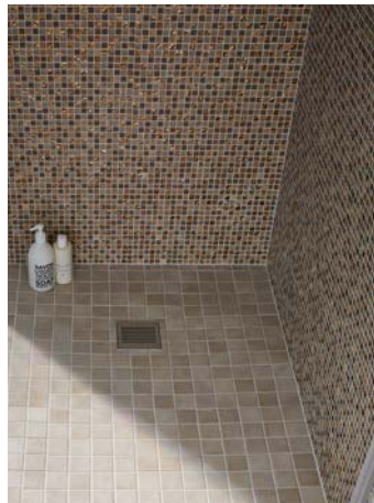
Rollstuhlbefahrbar bei einer Fliesengröße ab 50 x 50 mm.
