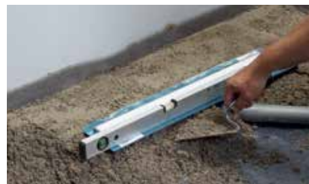
Шаг 2 – Укладка бетонной стяжки
