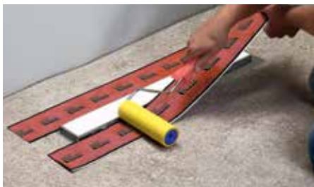
Шаг 3 – Наклеивание гидроизоляционной манжеты Seal System
