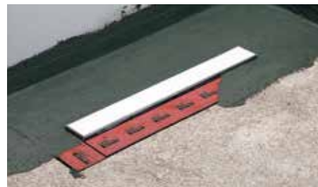
Шаг 4 – Нанесение гидроизоляционного слоя
